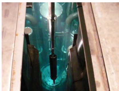
Вид на корпус реактора и бассейн выдержки. ТВЭЛ помещается в активную зону
